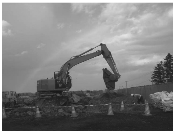
図-3 再生骨材製造状況
