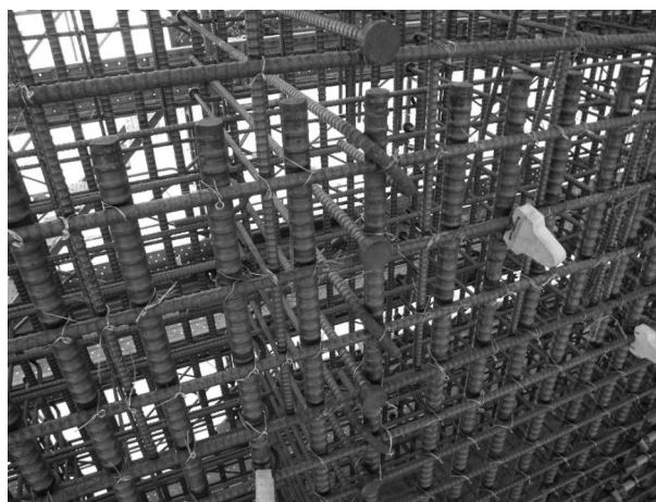
図-4 鉄筋組立完了
