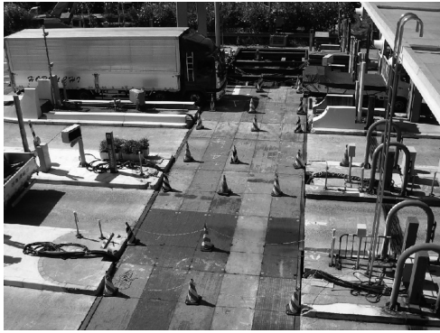
図-1 施工場所全景
