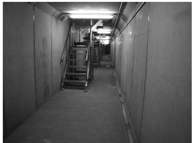
図-5 地下通路の完成
