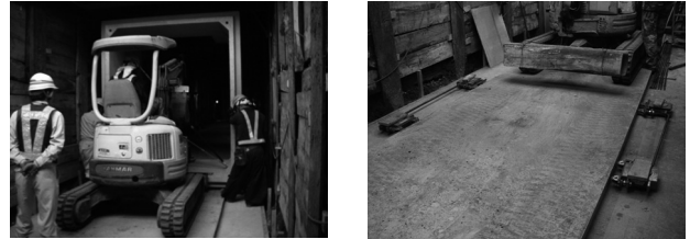
図-4 運搬中にズレ無いうよう基礎コンの形状をガイドラインとなるよう変更した。
