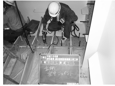
図-5 仮ボルト締付状況
