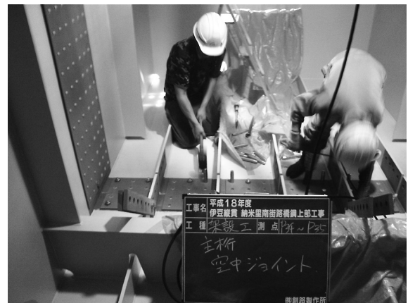
図-1 大ハンマーによる作業
