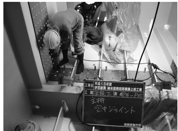
図-2 インパクトレンチによる作業
