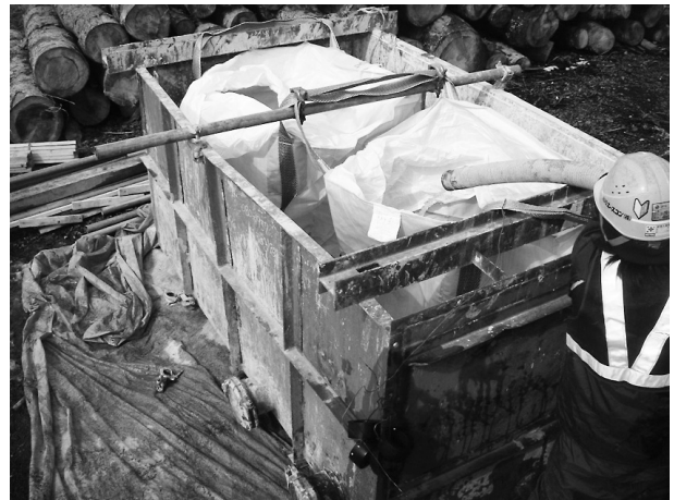
図-3 鋼製タンク及びトンパック
