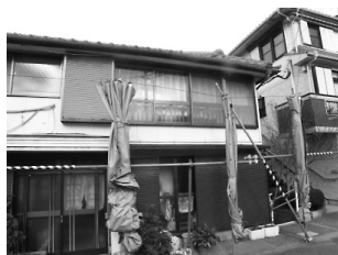
図-4 シート養生時（裾部緊縛）
