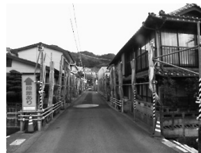
図-1 シート養生状況
