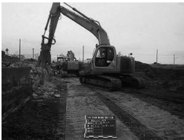
図-3 バックホウ油圧圧砕機解体状況
