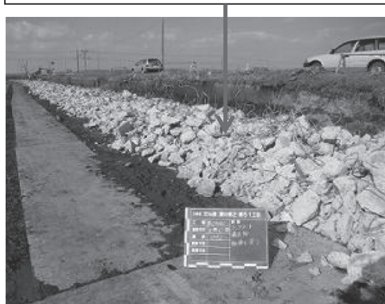
図-5 旧コンクリート水路解体完了
