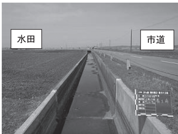
図-2 旧コンクリート水路解体前
