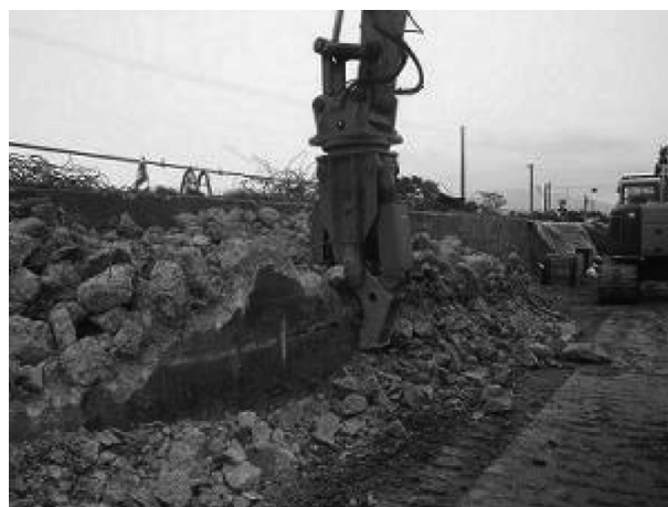
図-4 バックホウ油圧圧砕機解体状況
