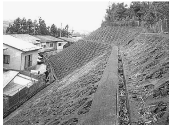
図-1 対象箇所（空石積みプレキャスト枠工）
