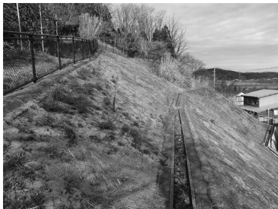
図-4 コケ緑化施工地
