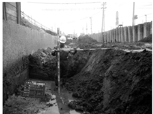
図-2 攪拌混合による付加土（残土）
