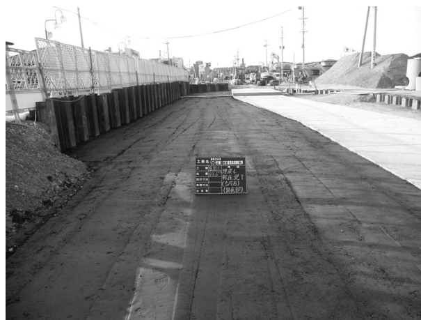
図-3 付加土利用による路床盛土
