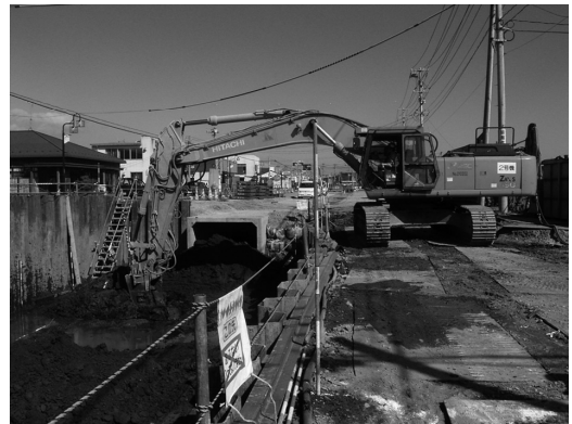
図-1 攪拌混合改良状況
