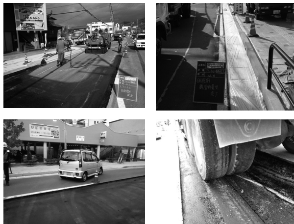
図-5 既存街路を汚す事無く環境配慮した施工状況
