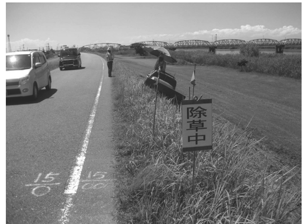
図-2 法面での機械刈状況
