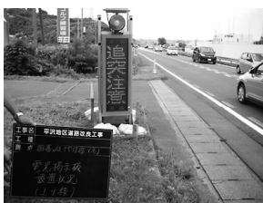
図-3 電光掲示板設置状況
