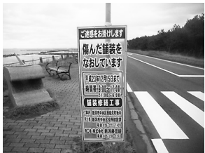
図-7 スケルトン看板設置
