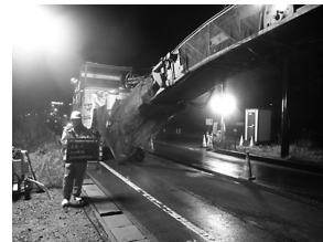
図-5 粉塵防止対策ネット設置
