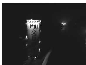
図-3 蛍光灯・セイフティーボール設置
