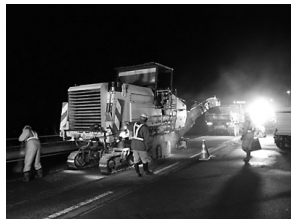
図-4 深掘切削機施工状況
