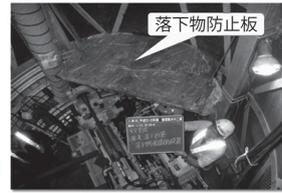
図-3 「落下物防止板」設置状況
