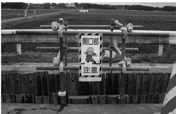
図-3 掘削継手箇所の転落防止柵
