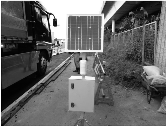
図-2 カーデル設置状況（感知機側）
