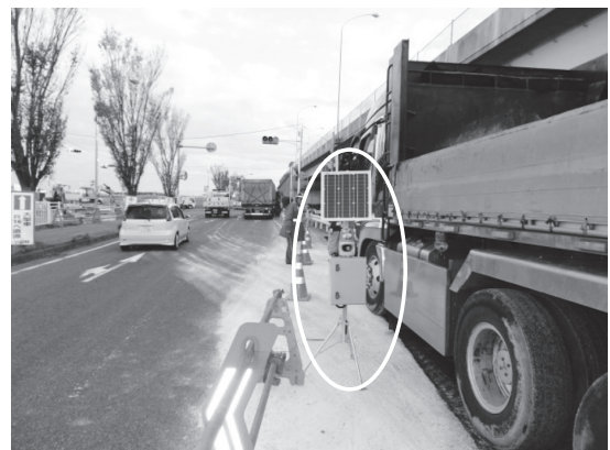
図-1 カーデル設置状況
