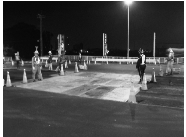
図-3 敷板設置状況
