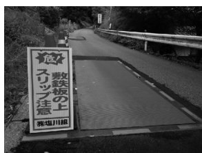
図-1 埋設物の養生
