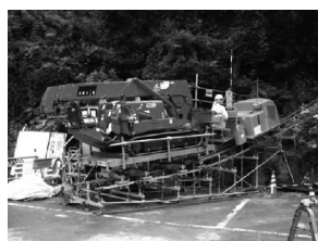
図-2 仮設モノレール
