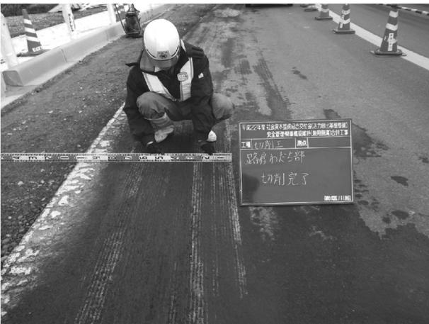
図-6 切削によりわだち掘れの解消
