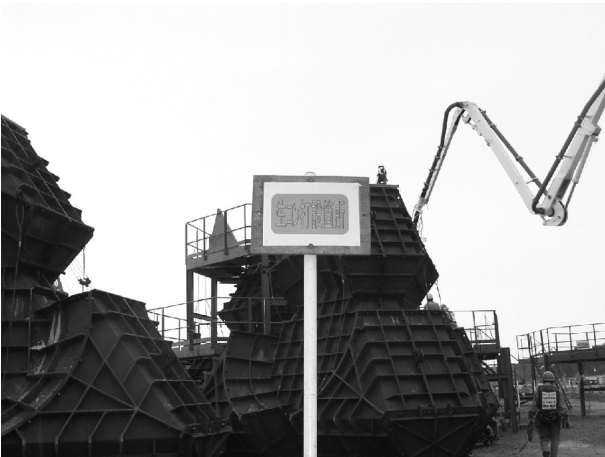
図-2 作業区域明示状況－その2
