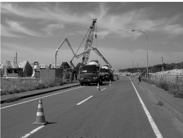
図-3 道路使用、誘導員配置状況
