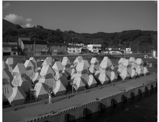
図-4 エプロン養生状況
