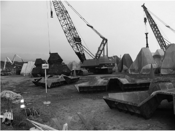
図-1 作業区域明示状況－その1
