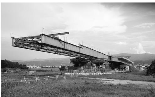
図-3 合成床版を搭載した送出し架設
