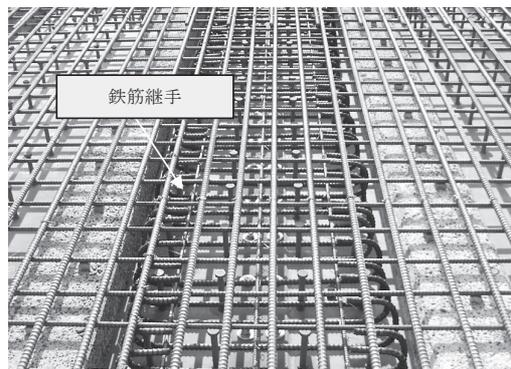
図-5 鉄筋継手
