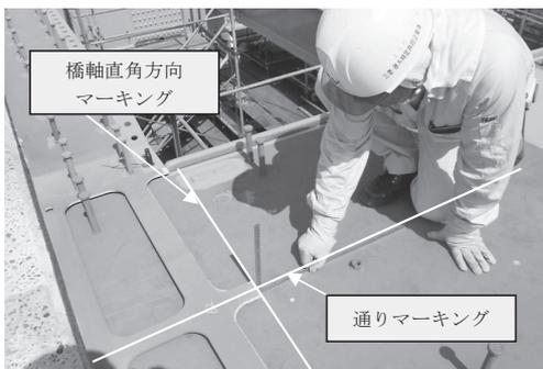
図-4 底鋼板パネルの位置合わせ
