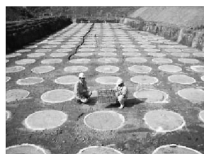
図-7 深層改良完了
