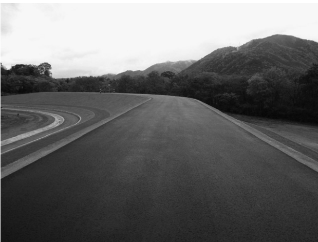
図-1 築堤盛土全景写真
