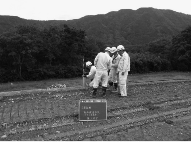
図-2 TS出来形測定状況
