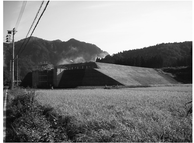
図-3 高路体盛土完了 (H=10m)
