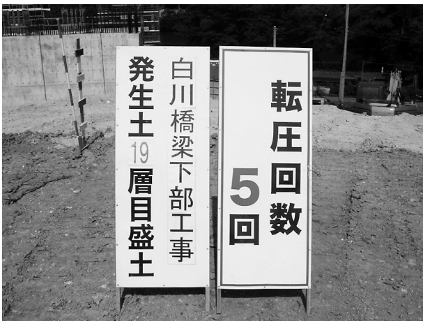
図-2 看板による工事名と転圧回数表示
