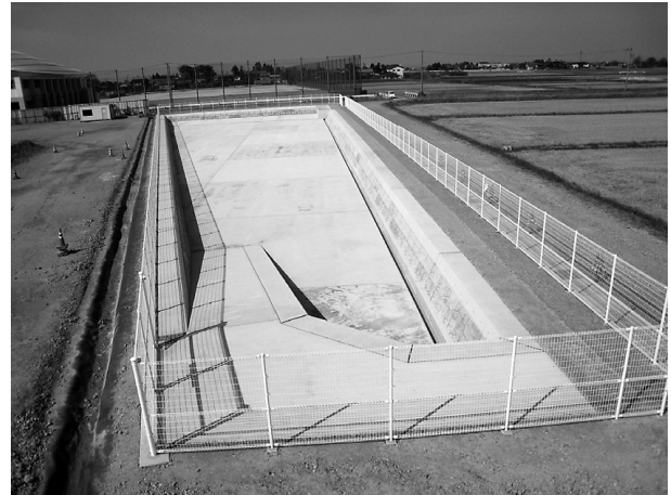
図-4 調整池全景
