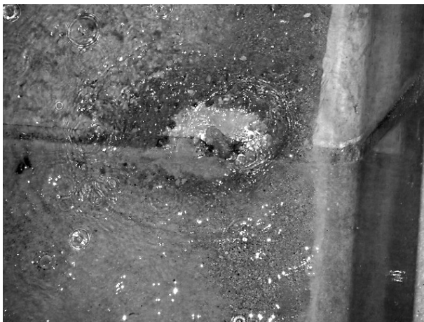
図-3 渠底部からの排水状況
