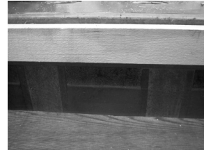
図-5 透明型枠による充填確認
