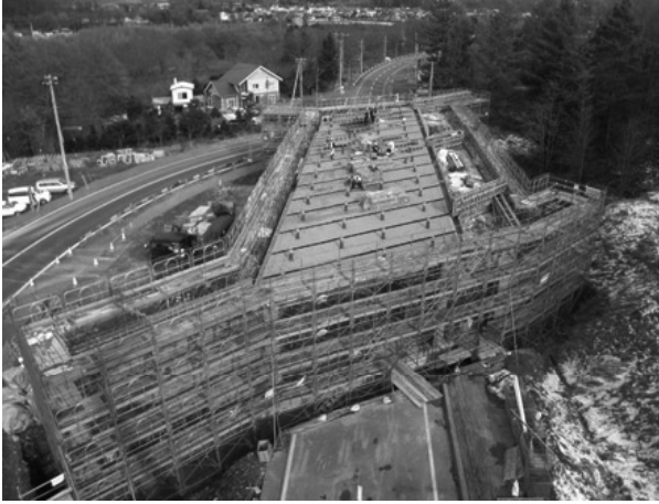
図-3 施工中全景
