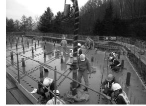
図-4 コンクリート打設状況
