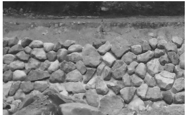
図-3 施工後半の巨石積工
