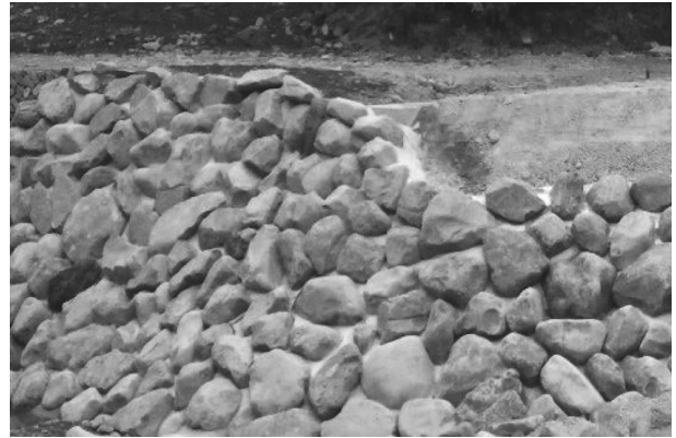
図-2 施工当初の巨石積工
