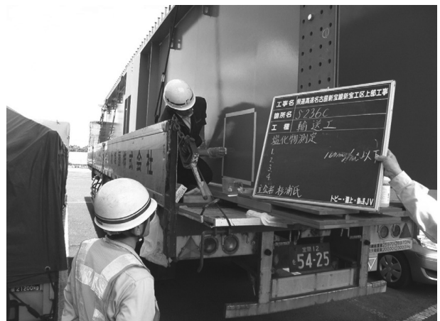
図-1 付着塩分量測定状況
