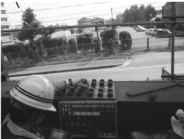
図-2 塗膜厚測定（現場塗装前）
