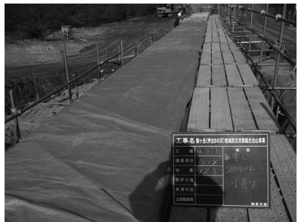
図-4 打ち上がりコンクリート養生状況
