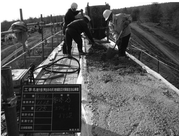
図-2 ハイパーネット上部へのコンクリート投入状況
