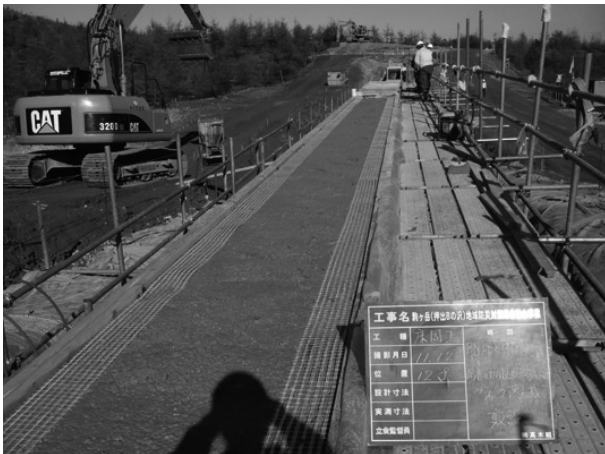
図-1 ハイパーネット敷設状況
