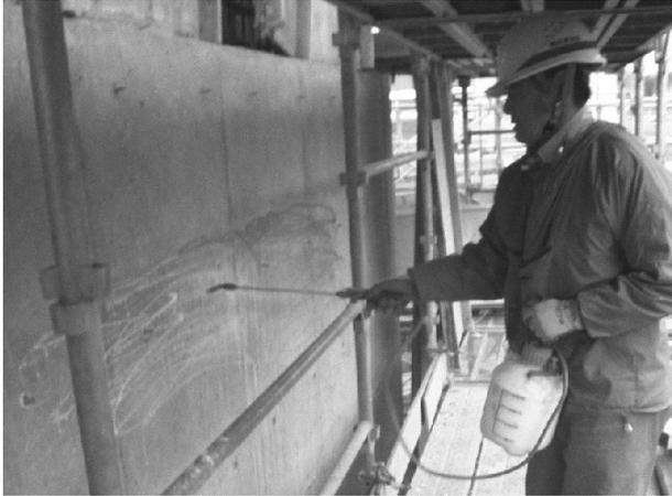
図-6 塗膜養生剤塗布状況
