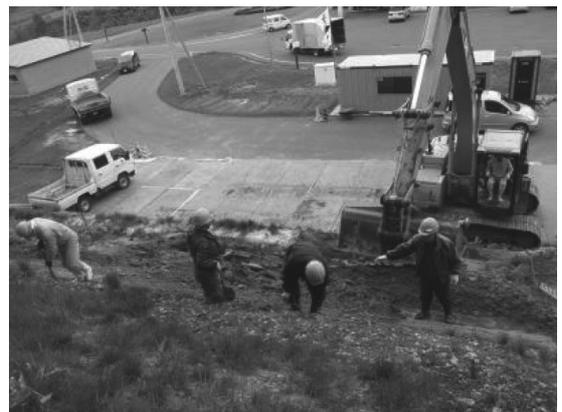
図-1 法面掘削作業
