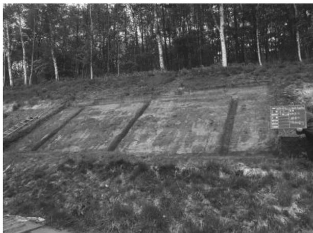
図-4 暗渠排水設置（掘削完了）
