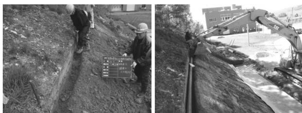
図-3 人力掘削・暗渠管設置
