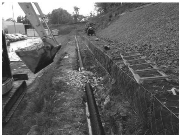
図-5 流末暗渠管設置
