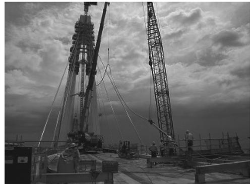
図-6 主ケーブル架設状況
