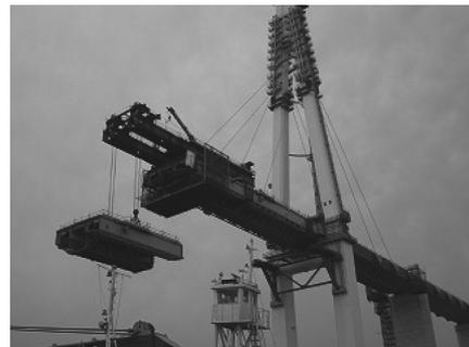
図-1 揚重機による架設状況
