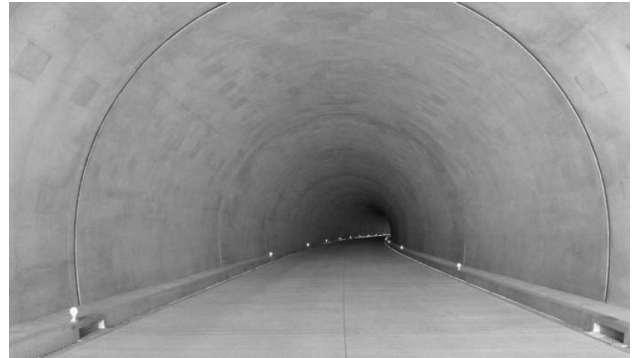
図-5 覆工コンクリートの出栄え
