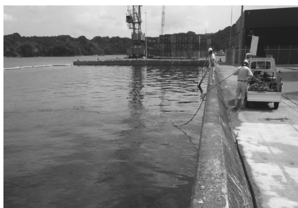
図-4 潜水調査状況
