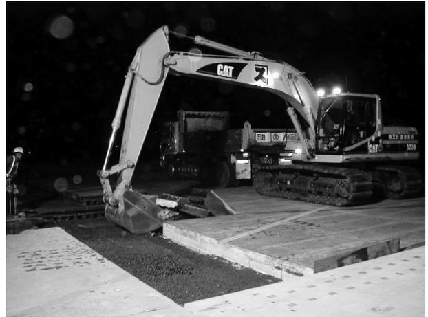
図-2 アスファルト撤去状況
