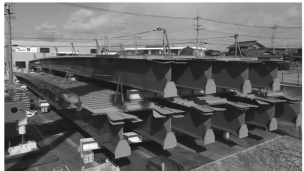
図-3 主桁部材地組立
