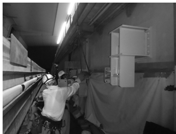
図-6 ダンパー取付け状況
