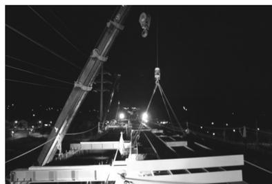
図-6 合成床版架設状況
