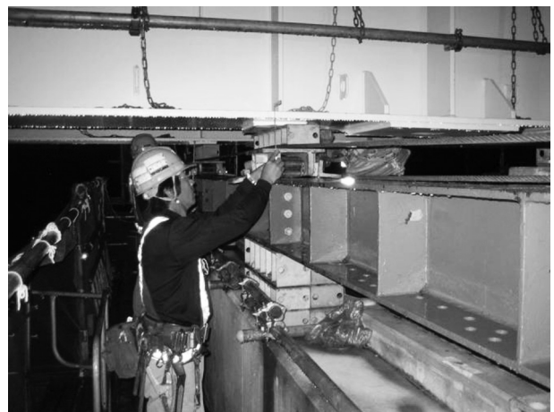
図-4 横取り状況（その2）
