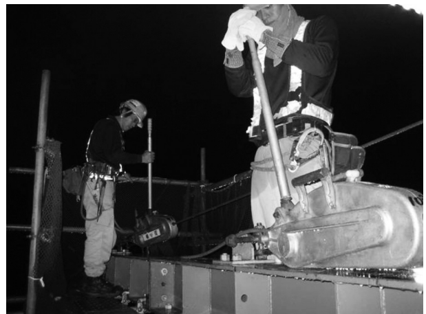
図-3 横取り状況（その1）
