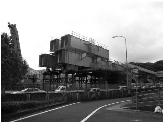
図-4 桁上地組立状況
