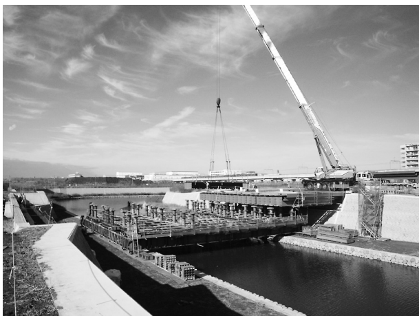
図-3 架設状況 (A2側)
