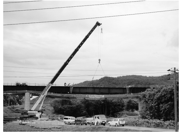
図-3 落とし込み架設状況
