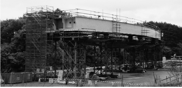
図-2 地組立完成
