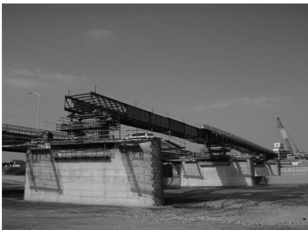
図-3 G2桁送り出し (SP3到達)
