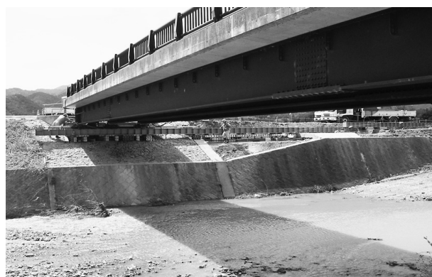
図－6 横引き作業状況
