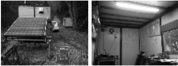
図-1 太陽光パネルとLED照明
