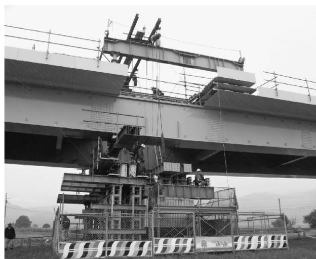
図-6 P1 送出し設備解体状況
