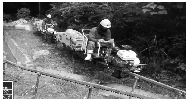
図-3 モノレール連行運転状況
