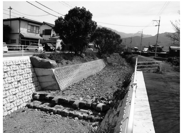
図-2 着工前状況写真
