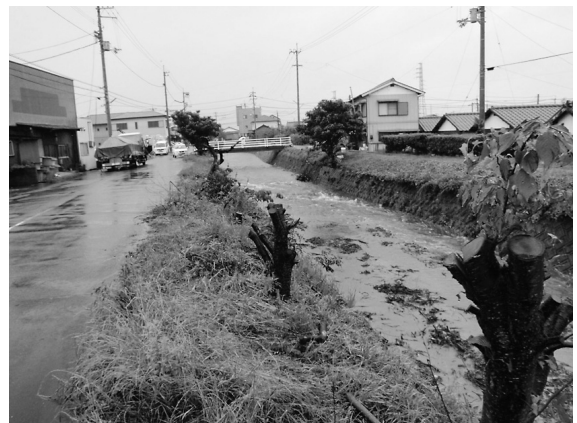
図-3 降雨時状況写真
