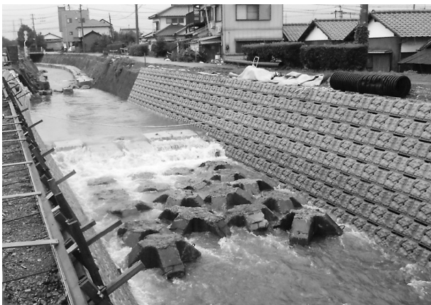
図－4 仮設護床工状況写真
