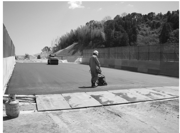
図-3 橋梁部養生状況
